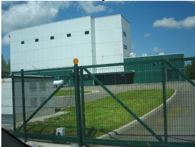
Foto 5.5 Ahtme veetöötlusjaam. Välisvaade
