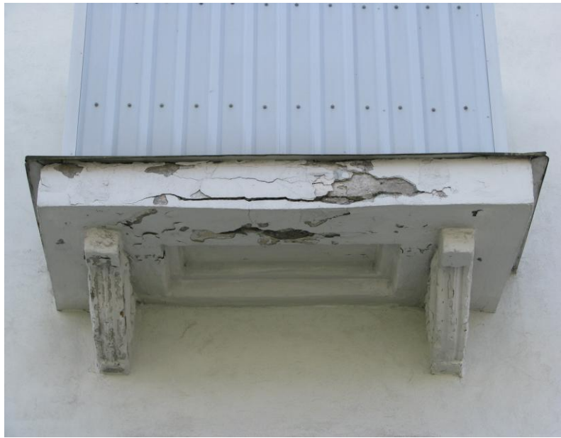
Foto 1. Esialgselt on olnud rõdulmetallvarbadest piire, profiilplekist asendus ei ole sobilik. Lahtine betoon on jäetud eemaldamata ja sarrusvarraste korrodeerumist ei ole peatatud. Rõdu plaat laguneb intensiivselt hoolimata värskest teostatud remondist.
